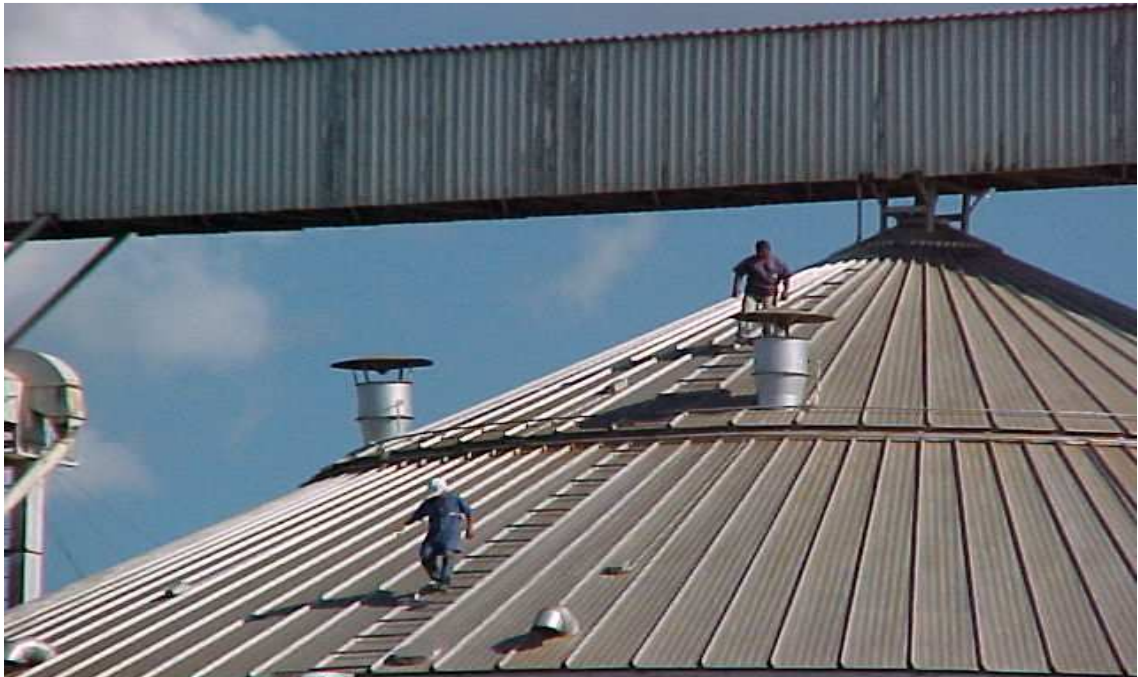
Figura 18 – Exemplo de trabalho em altura fora de norma. Fonte – arquivo pessoal.
