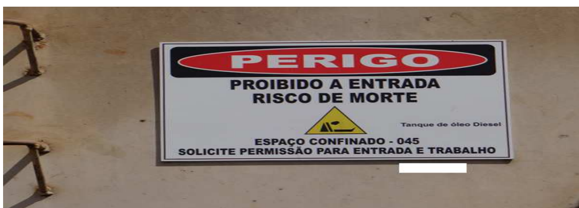
Figura 20 – Exemplo placa de identificação de espaço confinado. Fonte – arquivo pessoal.
